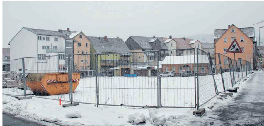
Auf dem Union-Areal soll der Drei-Kronen-Hof entstehen. Das zweite Gebäude von links (fleischfarben) hat die Wohnbau gekauft und will es zugunsten einer Tiefgaragenzufahrt abreißen lassen. FOTO: DOROTHEA HECHT
