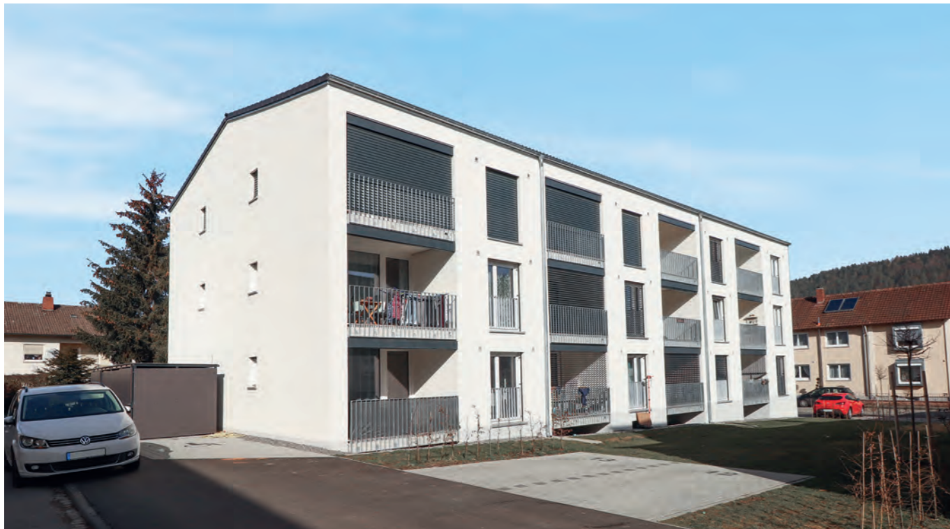
Neue Gemeinschaft: Goethestraße 14 + 14/1 in Tuttlingen (12 Wohnungen)
