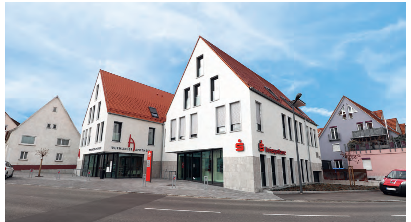
Neue Gemeinschaft: Untere Hauptstraße 10 in Würmlingen (10 Wohnungen 2 Gewerbeeinheiten)
