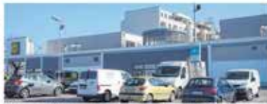
Anderswo ist Wohnraum auf Dächern bereits entstanden: Auf dem Dach der L&L-Filiale an der Bornhäuser Straße in Berlin im Bezirk Prenzlauer Berg sind Wohnungen gebaut worden.
